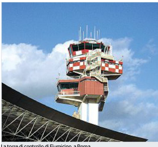
La torre di controllo di Fiumicino, a Roma
