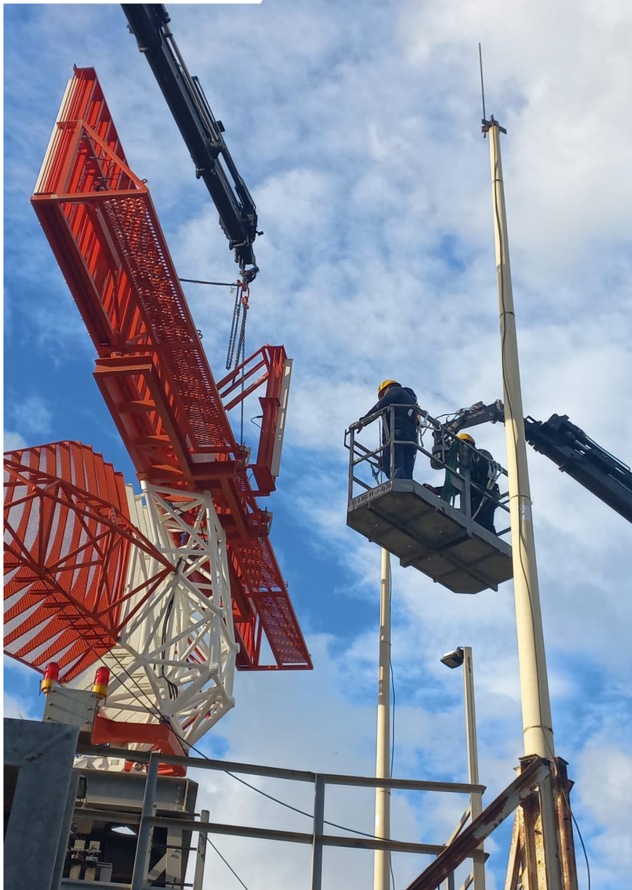
Cambio della ralla di rotazione del radar di Olbia. Personale Techno Sky all'opera
