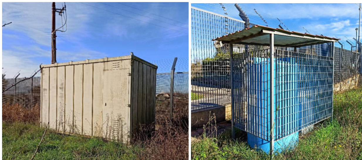
Fig. 13 – cabina elettrica esistente (sul retro, a confine, il palo di alimentazione) e serbatoio idrico
