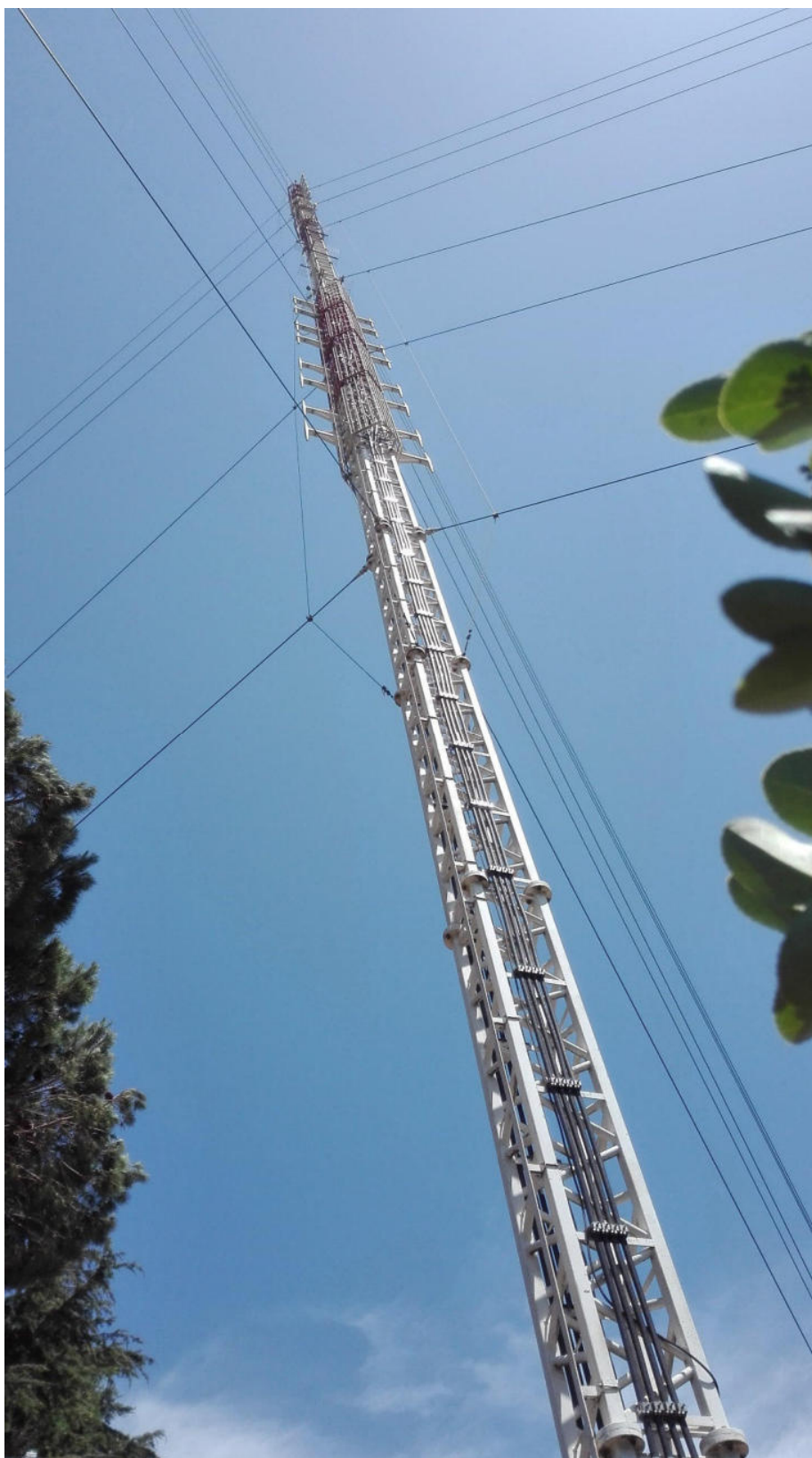
Fig. 10 - vista d'insieme del traliccio
