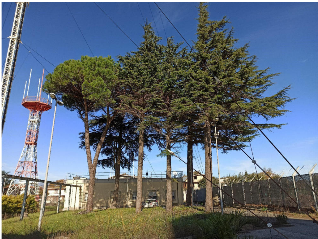
Fig. 15 – alberi interferenti con gli stralli
