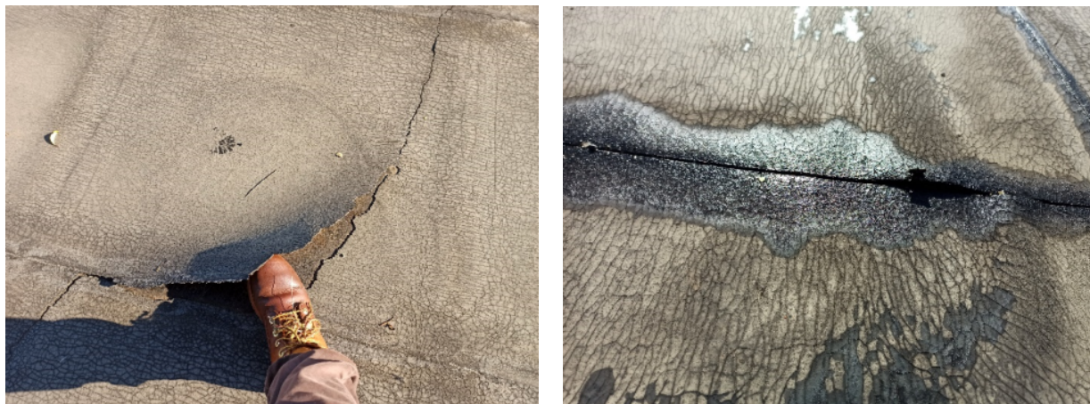
Fig. 14 – guaina impermeabilizzante copertura edificio apparati
